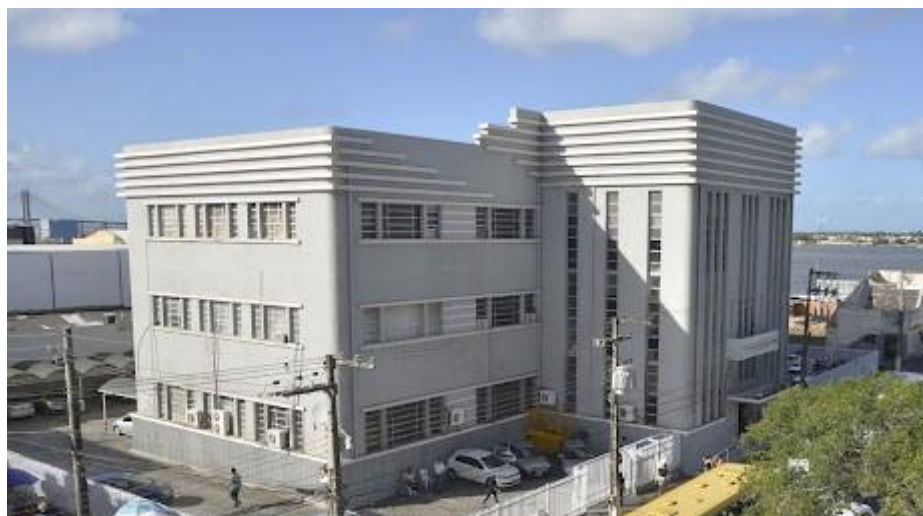
FIGURA 1 – SEDE DO SERGIPEPREVIDÊNCIA
